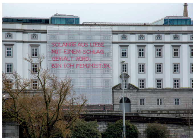
SOLANGE Katharina Cibulka, Verhülltes Baugerüst SOLANGE © Katharina Cibulka, courtesy ECoC Bad Ischl Salzkammergut 2024
